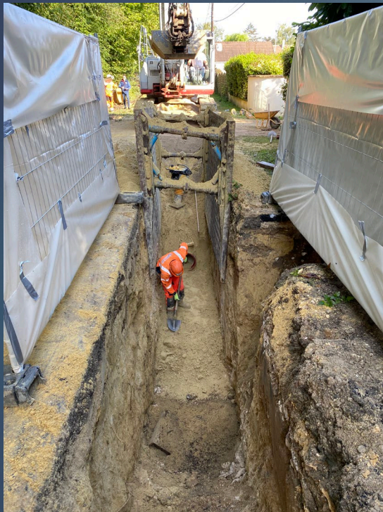
Vue terrassement de tranchée après dépose de la canalisation en amiante-ciment
