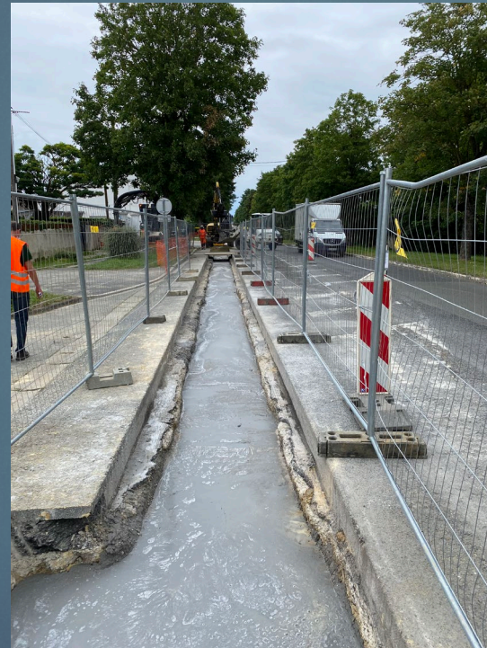
Remblaiement de la tranchée du réseau EU en matériau autocompactant
