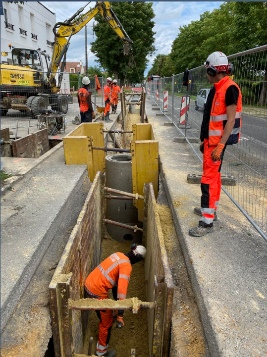
Pose du réseau EU
