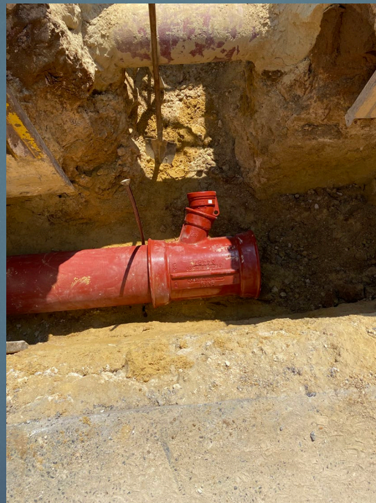
Vue d'un raccordement par culotte en fonte 400/150mm
